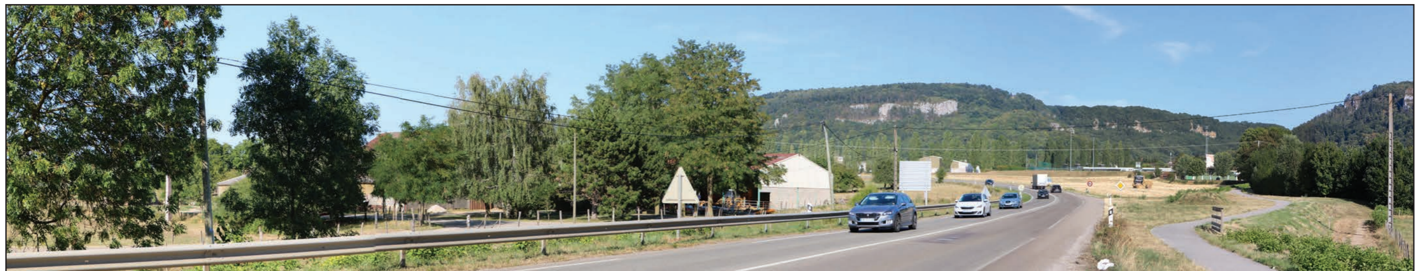
Panoramique P047 - Perception depuis le giratoire à l'entrée Ouest de Poligny - 4,3 km
